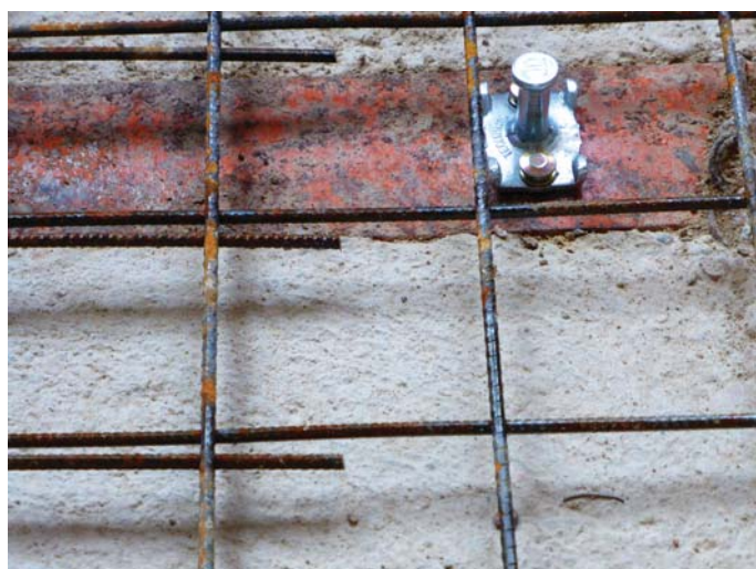
Connettore fissato correttamente
