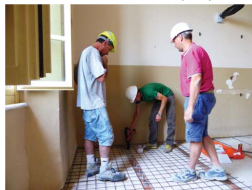
Istruzione del personale sul metodo di posa dei connettori
