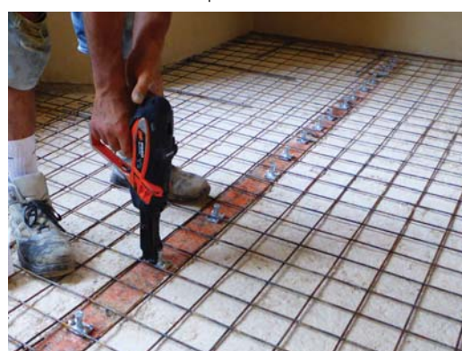
Fissaggio dei connettori con chiodatrice a sparo data in dotazione
