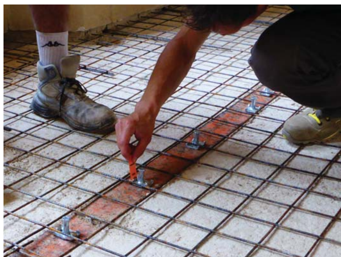
Controllo della giusta profondità di infissione del chiodo
