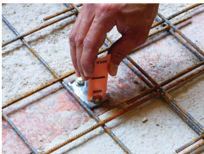
Il chiodo deve penetrare nella putrella e stare entro un minimo/massimo di profondità
