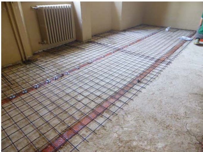
Posizionamento dei connettori come da prescrizione dello strutturista
