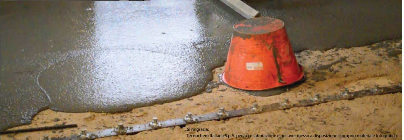
Applicazione sul fresco di curing antievaporante
