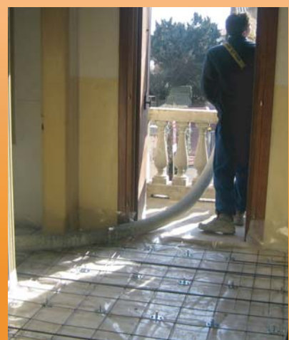
La soletta è stata armata con rete elettrosaldata. L'operatore segue tramite radiocomando la pompa del calcestruzzo della betoniera.
