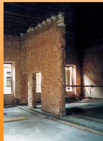
Dopo la stesura delle maglie elettrosaldate la cui funzione è quella di ripartire omogeneamente gli sforzi, è stato fatto il getto finale. Va ovviamente sottolineato che prima dell'esecuzione del getto i solai vanno opportunamente puntellati per il periodo necessario alla stagionatura del calcestruzzo.
