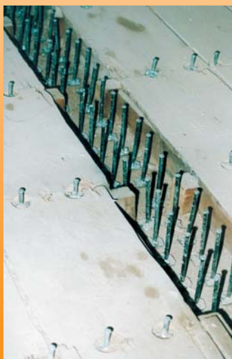
connettore a diretto contatto del trave principale e sui travetti secondari
