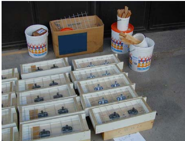
Foto 1: Particolare delle casseforme, dei connettori e della rete metallica di armatura
