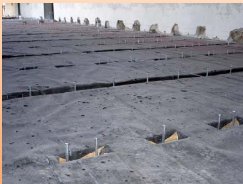
E' stato steso un telo impermeabile e traspirante Delta-Fol PVE Dorken con apposita graffettatrice. Quindi i connettori vengono fissati sopra.
