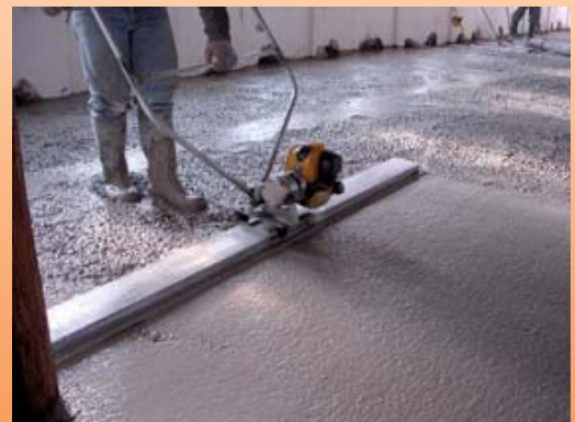
Il calcestruzzo viene livellato tramite staggiatrice automatica.
