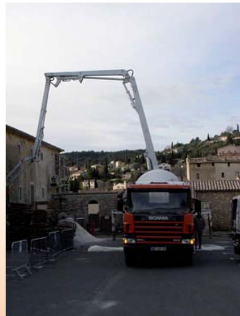
L'autobetoniera esterna fa fluire il calcestruzzo all'interno dei locali.
