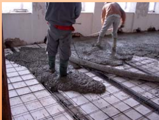
Il calcestruzzo fluisce entro i setti connessi.
