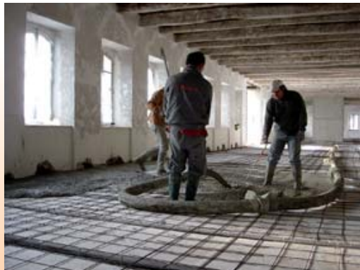
Il calcestruzzo viene steso tramite tubo-getto direttamente dalla autobetoniera.
