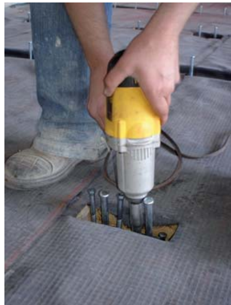
Fissaggio delle viti tirafondi date a corredo dei connettori Maxi.
