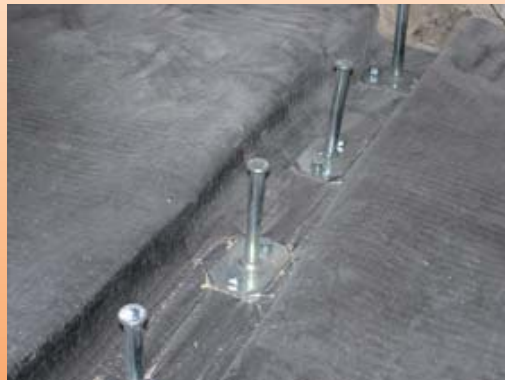
Particolare dei connettori MAXI fissati sopra il telo.
