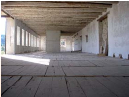
E' stato messo a nudo il tavolato e si è proceduto a fresatura per andare a fissare i connettori MAXI direttamente sulle travi portanti.
