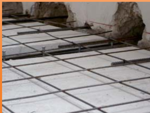
Sono stati fatti appositi attacchi a muro per legare la soletta portante alle murature.
