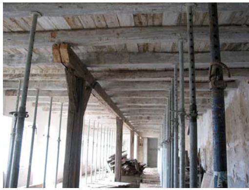
Puntellatura dei solai.
