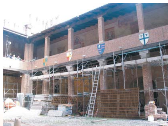
Vista del Loggiato Superiore oggetto dell'intervento, dall'interno del cortile.
