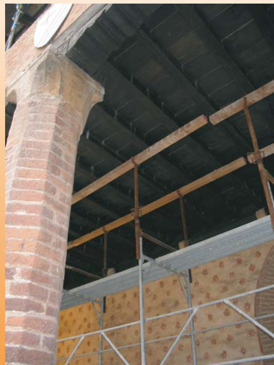
I solai vanno sempre puntellati prima dell'esecuzione del getto per garantire una corretta esecuzione dell'opera.
