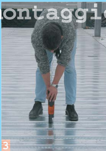
Dopo la stesura delle lamiere grecate si può procedere all'infissione dei connettori. Con una unica operazione si bloccano le lamiere e si realizza la connessione. Non è richiesta manodopera specializzata e le attrezzature possono anche essere noleggiate.
