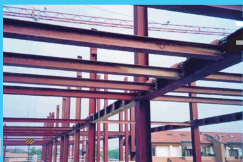
Si procede al montaggio dei pilastri e delle travi di acciaio
