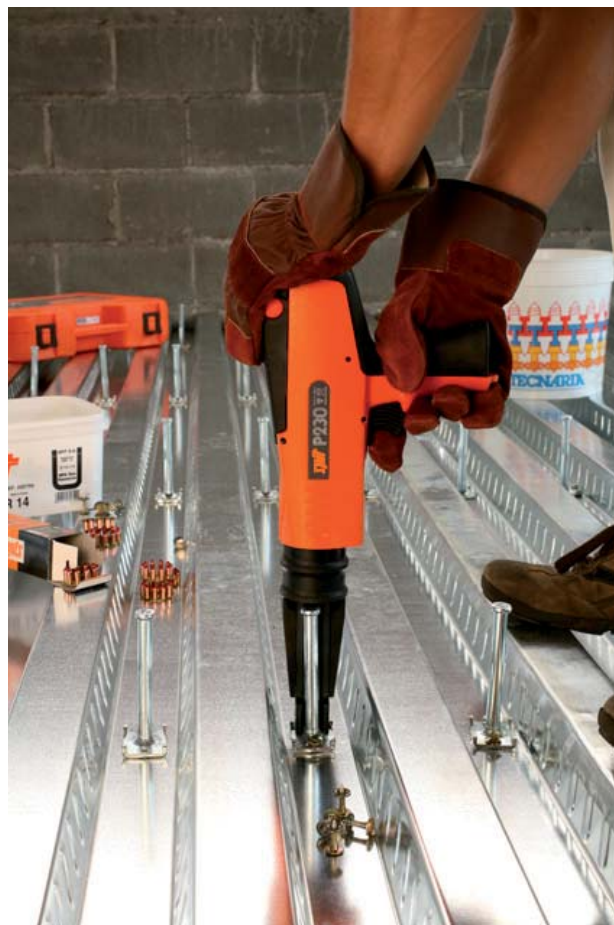
La chiodatrice a sparo effettua fissaggio diretto del chiodo senza uso di preforo
